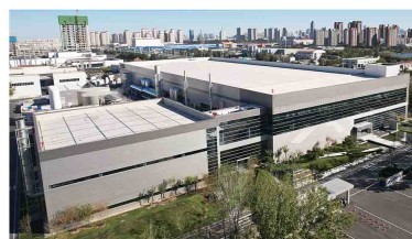
天津半导体硅片项目总承包 Tianjin Semiconductor Wafer Project EPC
