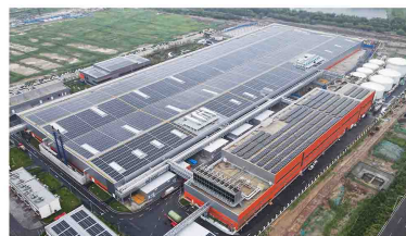
天津光伏切片项目总承包 Tianjin PV Wafer Project EPC
